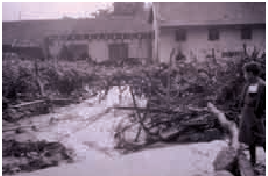
Der alte Ziegelstadel der Benediktinerabtei Muri Gries, aufgenommen von der Hauptstraße, wurde von Schlamm und Geröll arg in Mitleidenschaft gezogen.
