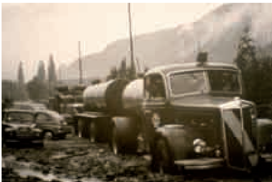
Die Hauptstraße durch das Dorf war derart vermurt, dass sogar große Tankwagen, die Wein transportierten, mit Wein im Schlamm stecken blieben.
