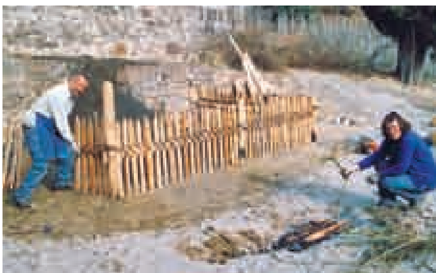
Aufstellen eines Speltenzaunes beim Aichner- oder Aichhorn-Hof im Winkel. Luis Staffler windet die „Lattlen“ mit Weiden an die Querlatten des Zaunes, während seine Frau Walltraud die Weiden vorweg anwärmt.
