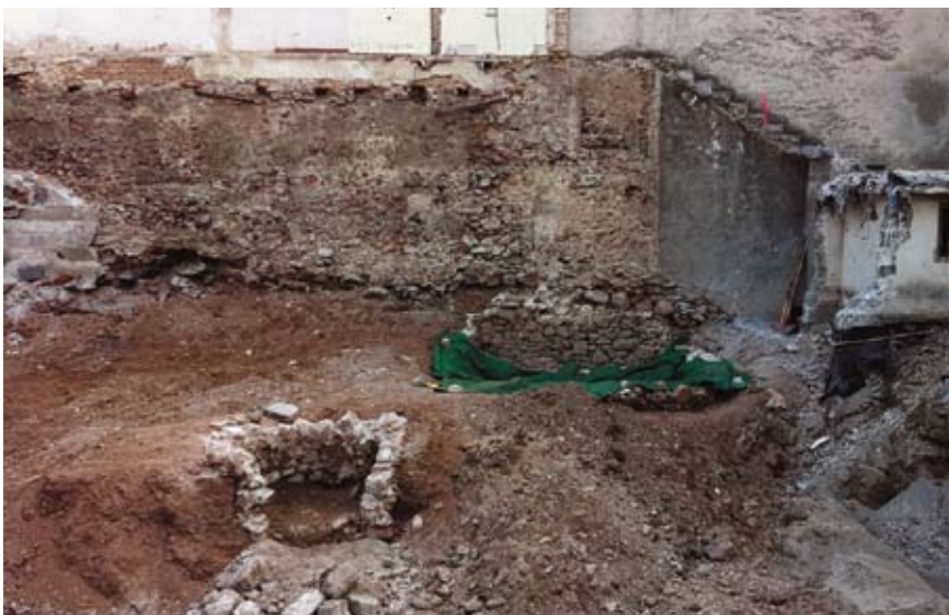
Während der Grabungsarbeiten, 2011
