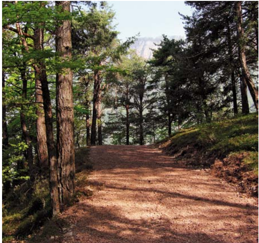
Der Forstweg „Grunerberg“ ermöglicht den Einsatzkräften im Falle eines Waldbrandes eine bessere Zufahrt.
