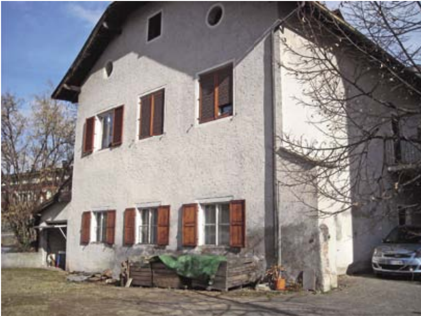
Nel 2011 inizieranno i lavori di ristrutturazione della canonica.
